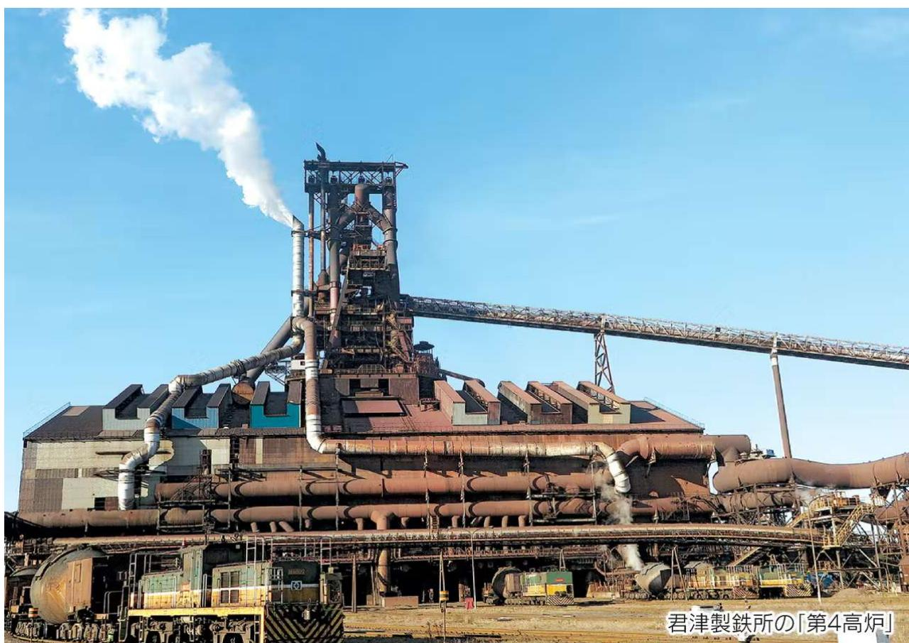
東京ドーム220個分もの敷地を誇る君津製鉄所。東門から車を走らせること15分。赤茶けたサビに覆われた工場群の端に立っているのが、「水素製鉄」の試験高炉だ。隣に立つ赤銅色がむき出しの巨大高炉とは異なり、高さ35メートルほどの水色の覆いですっぽりと囲まれている。高炉と原料の山に囲まれるために周囲からは見えない位置に立つが、それでも中が見えないようにするのは、絶対の機密性を保つためだ。
